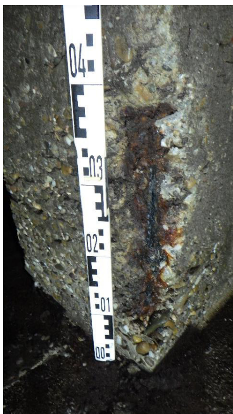
Abb. 2.21: Stützenfuß nach Öffnung des Kiesnestes mit stark korrodierter Bewehrung
