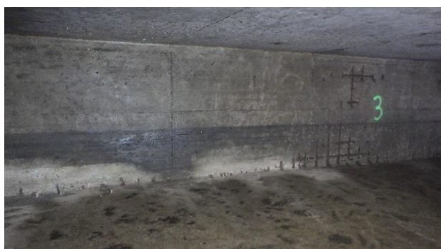
Abb. 2.9: Wandfläche mit Entnahmestelle 3 -großflächiger Wandabschnitt mit freiliegender Bewehrung-
