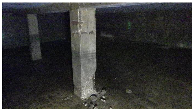
Abb. 2.18: Ansicht auf die geschädigte Stütze C
