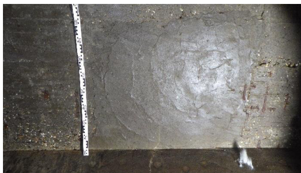
Abb. 2.14: Wandfläche mit nachträglicher Reprofilierung
