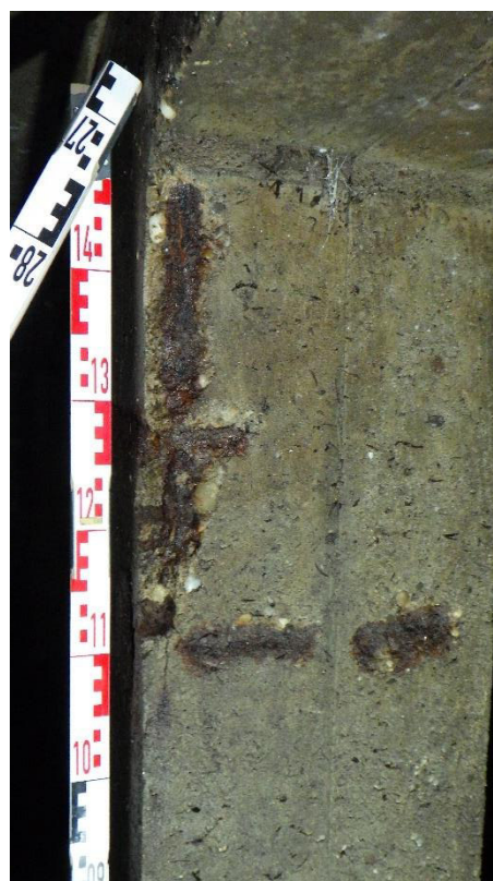
Abb. 2.22: Stützenkopf mit freiliegender Bewehrung
