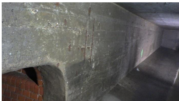
Abb. 2.3: Ansicht auf Wandfläche mit freiliegender Bewehrung infolge einer unzureichenden Betondeckung
