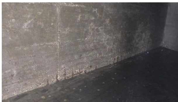
Abb. 2.6: freiliegende Bewehrung im Boden-Wand-Anschluss
