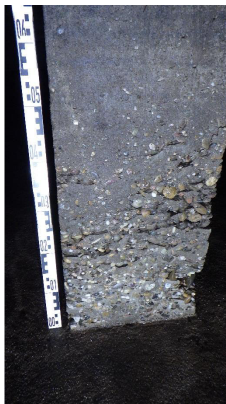
Abb. 2.20: Stützenfuß mit Kiesnest
