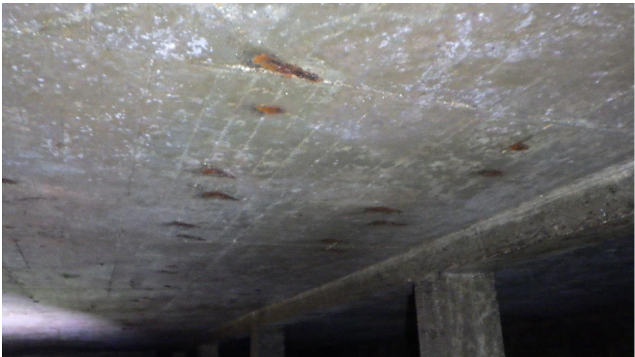
Abb. 2.23: exempl. Beispiel von der Sichtfläche der Deckenunterseite mit korrodierten Bewehrungsstählen in einer unregelmäßigen Verteilung
