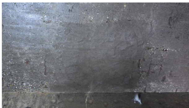
Abb. 2.4: freiliegende Bewehrungsstähle infolge einer unzureichenden Betondeckung
