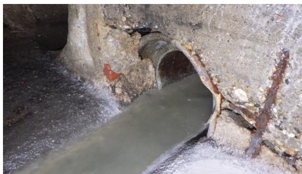
Abb. 2.15 und 2.16: Zustand der Wandflächen im Bereich der Rohrdurchführungen (Zu- und Ablauf)
