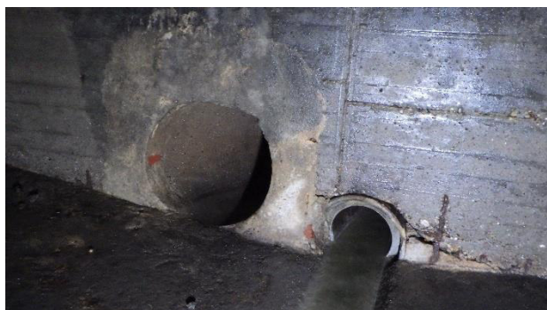
Abb. 2.15 und 2.16: Zustand der Wandflächen im Bereich der Rohrdurchführungen (Zu- und Ablauf)
